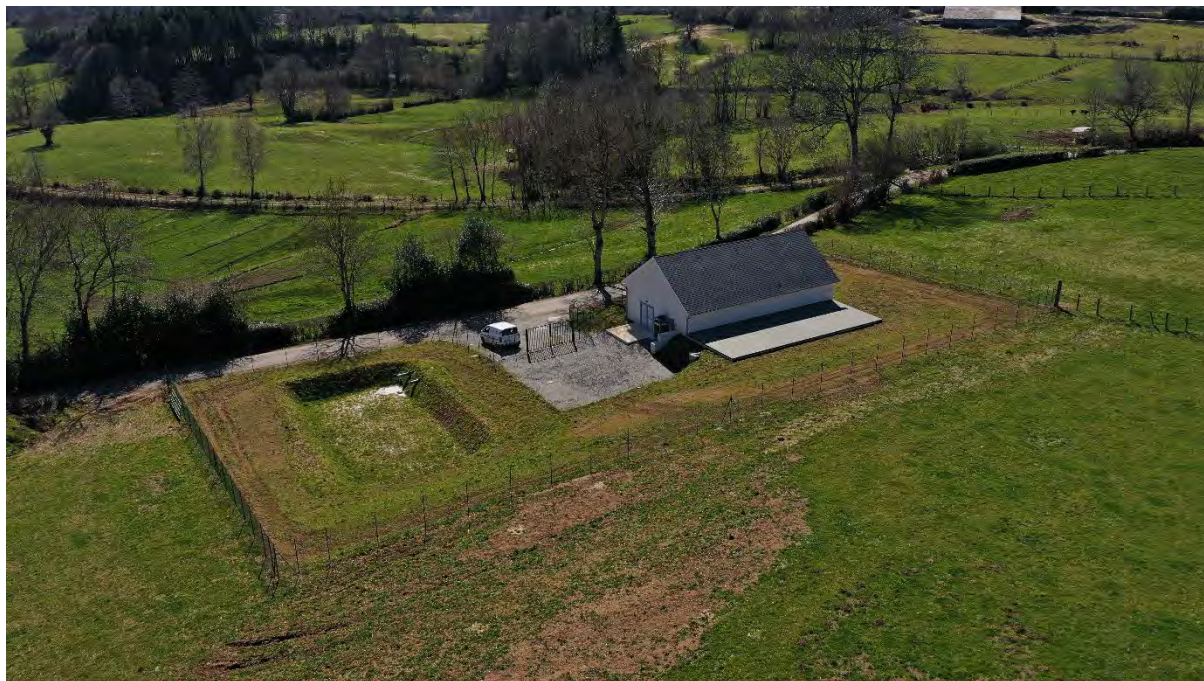
Figure 2: Vue aérienne de la station de traitement du Monteil (Couffy-sur-Sarsonne)
