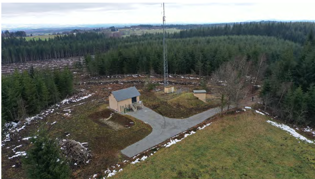
Figure 3 : Vue aérienne de la station de traitement de Montasserre (Aix)
