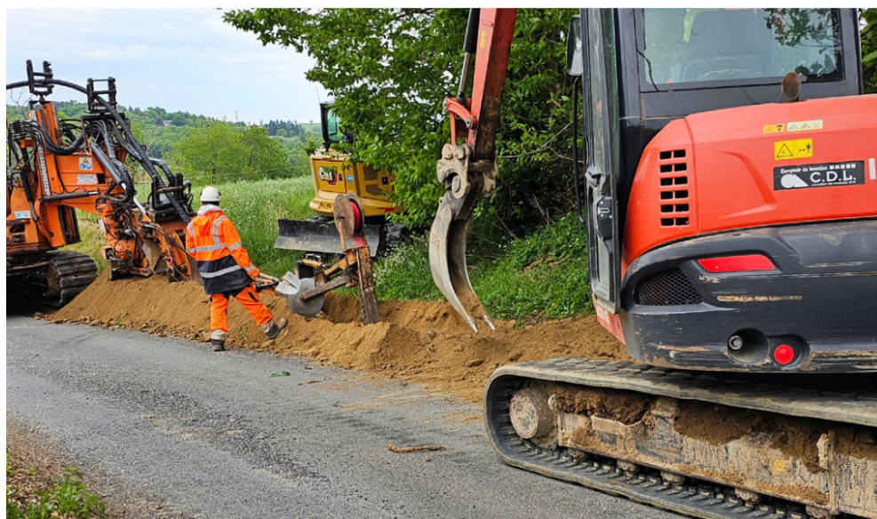
Enfouissement réseau HTA
